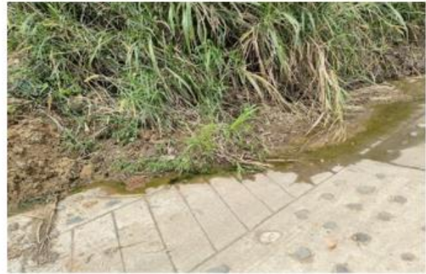
Imagen 28. Acumulación de vegetación sobre el Filtro [Fotografía]
