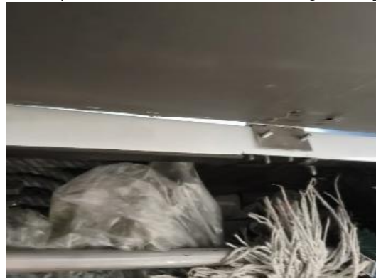
Imagen 17. Desprendimiento de tornillos en Bisagra silla [Fotografía]
