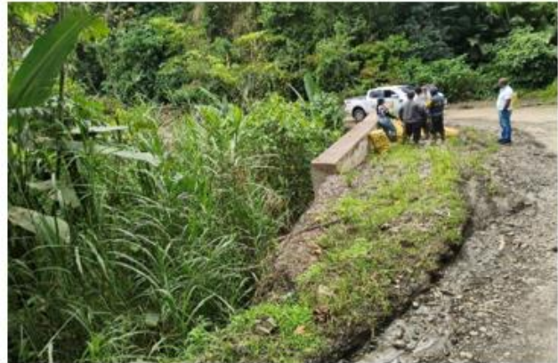
Imagen 20. Muro de contención en concreto reforzado 10m [Fotografía]
