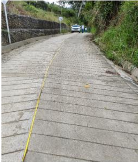
Imagen 23. Comprobación medida (140 metros), placa huella V2 [Fotografía]
