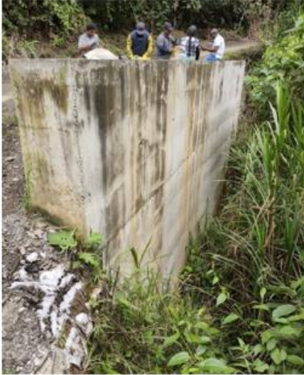
Imagen 19. Muro de contención en concreto reforzado 10m [Fotografía]
