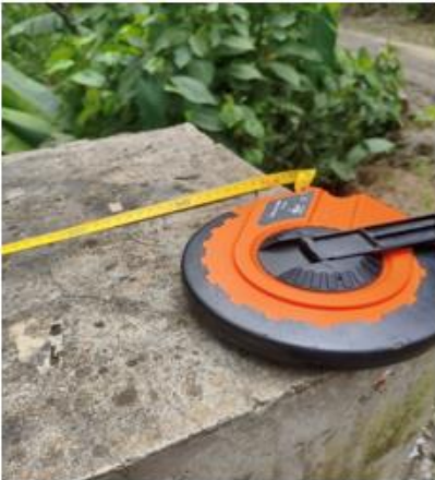
Imagen 21. Comprobación medida (10 metros), Muro de contención [Fotografía]
