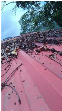
Imagen 17. Taponamiento canal desagüe IER Mesitas
