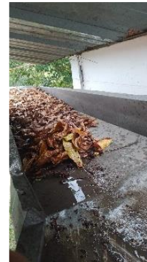
Imagen 18. Taponamiento canal desagüe IER Mesitas
