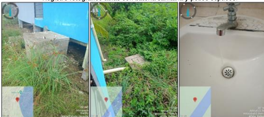
Imagen No. 11 Registro fotográfico aulas con batería sanitaria y pozos sépticos.
