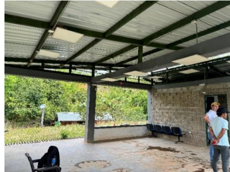
Vista interior Caseta Comunal Vda. La Palma
