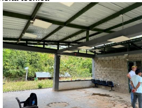
Vista interior Caseta Comunal Vda. La Palma
